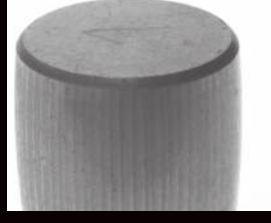
Elektrik akımından kaynaklanan oluklar
