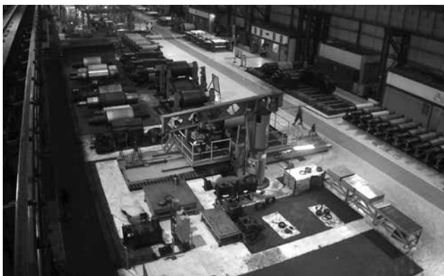
Fig. 279. MILLTEC rolling mill program.
