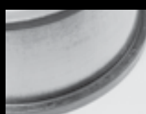
Hitzeschaden am Führungsbord
