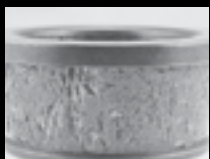
Ecaillage important dû à de lourdes charges
