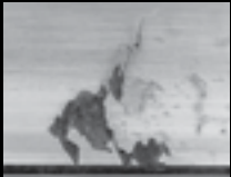
Ecaillage d'origine ponctuelle en surface (PSO).
