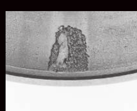
Rezultă exfoliere localizată pe calea de rulare
