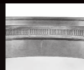
Bruciature da corrente elettrica
