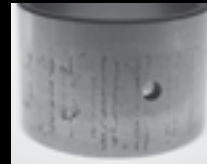
Oxidación y corrosión
