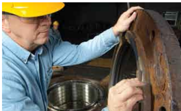
图28 轴承座盖板上也应无损伤
